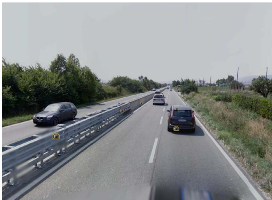
Figura 7: passaggio da barriera di sicurezza metallica a NJ in spartitraffico, dopo Rispescia
